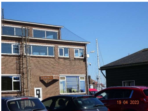
Gebouw 39 met netten visdiefvrij gemaakt
