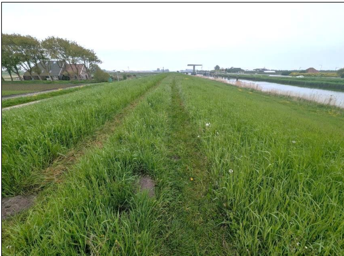
Oevertraject 1 vanaf naastgelegen dijk richting de spoorbrug.
