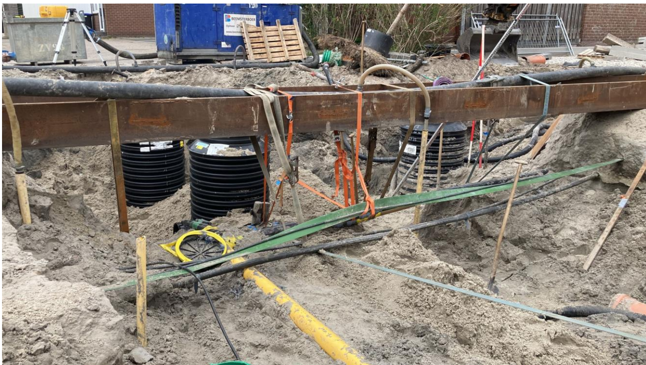
Figuur 7-1: Rioolwerkzaamheden in Den Helder
