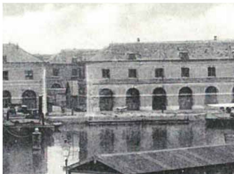
Afbeelding 119: de plint van de oorspronkelijke bebouwing aan de Maritieme Binnenhaven: de verdiepingsvloer is duidelijk lager dan de plint.
