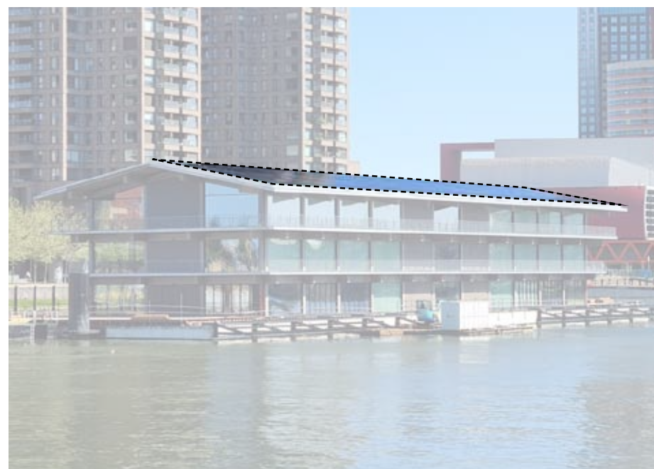
Afbeelding 46: zonedaken brandveilig geïntegreerd in het dakvlak
