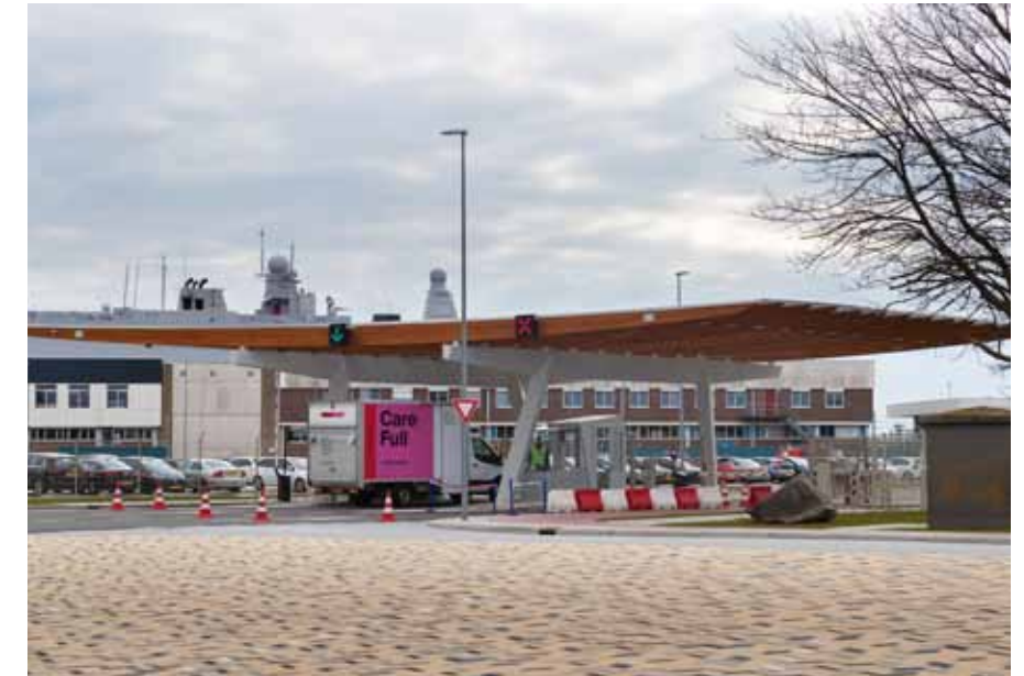
Afbeelding 73: toegangspoort naar het Nieuwe Diep
