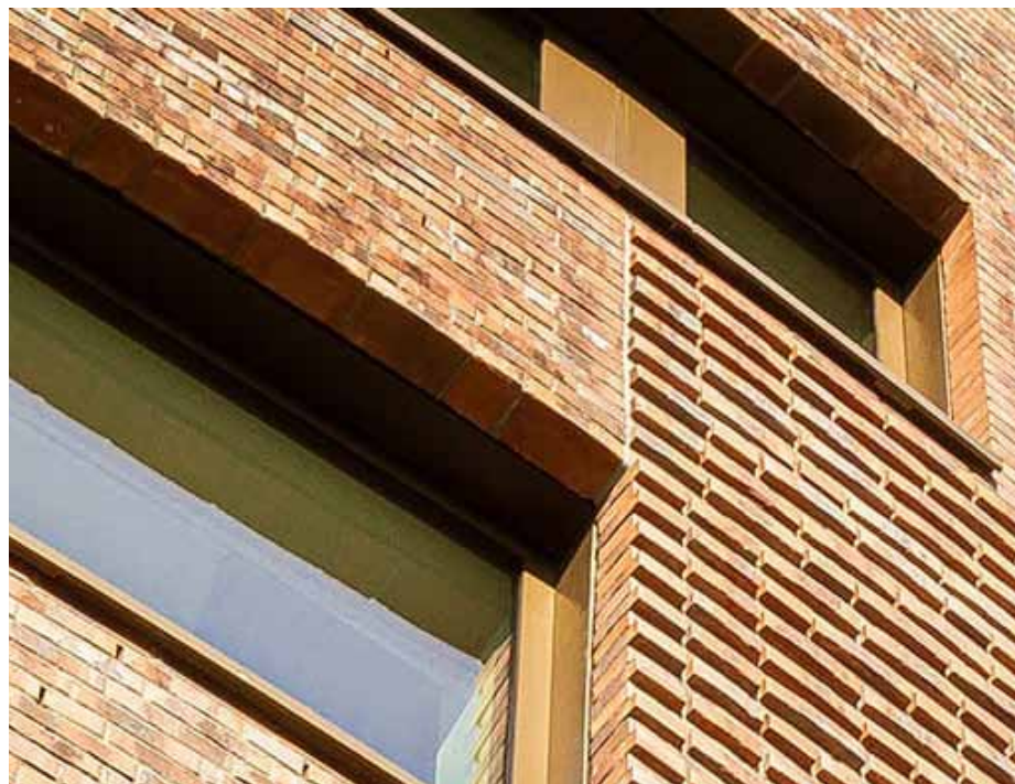
Afbeelding 45: thermische schil, diepe negge en zonwerend glas
