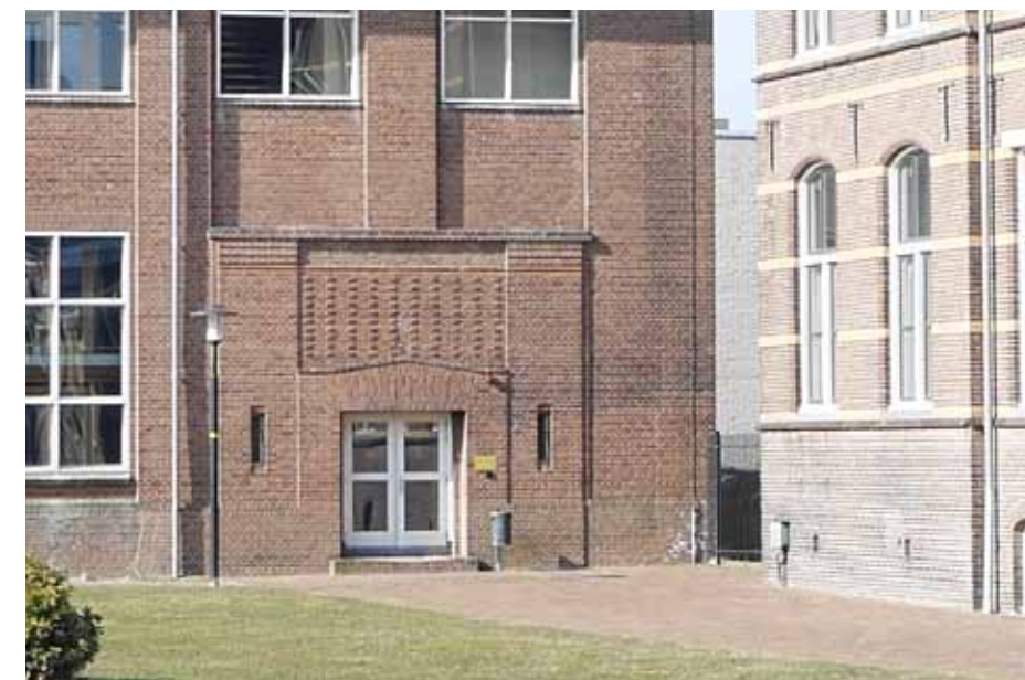
Afbeelding 120: bestaande entree bij het KIM
