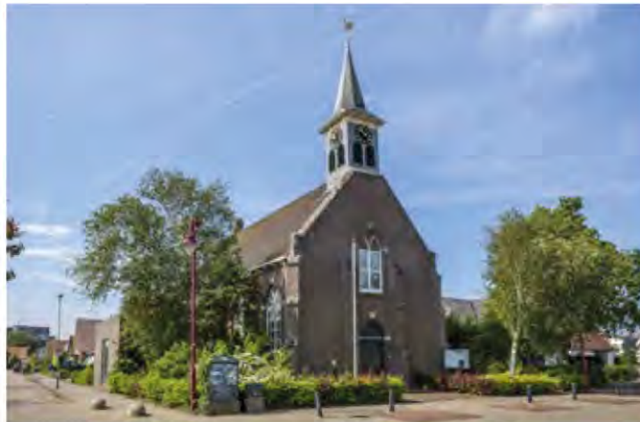
De Ontmoetingskerk in Julianadorp vervult zowel in stedenbouwkundig opzicht als in sociaal-maatschappelijk opzicht een belangrijke centrumfunctie voor het dorp.
