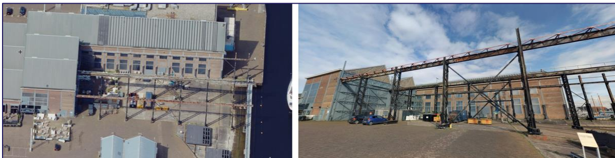
Figuur 6 | Huidige situatie nabij pand 51 op Willemsoord met de monumentale spanten (Bron: cyclomedia.nl)
