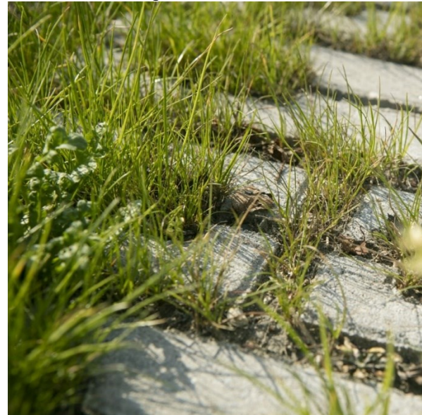
Kleine elementen verharding met schelpen toplaag en grasbetonstenen met grint
