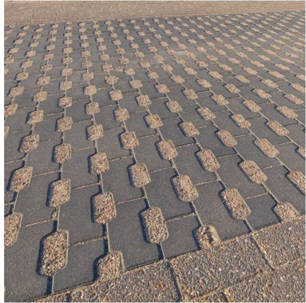
Kleine elementen verharding met schelpen toplaag en grasbetonstenen met grint
