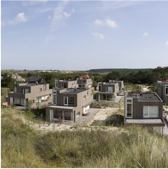
Verschijningsvorm plat dak
