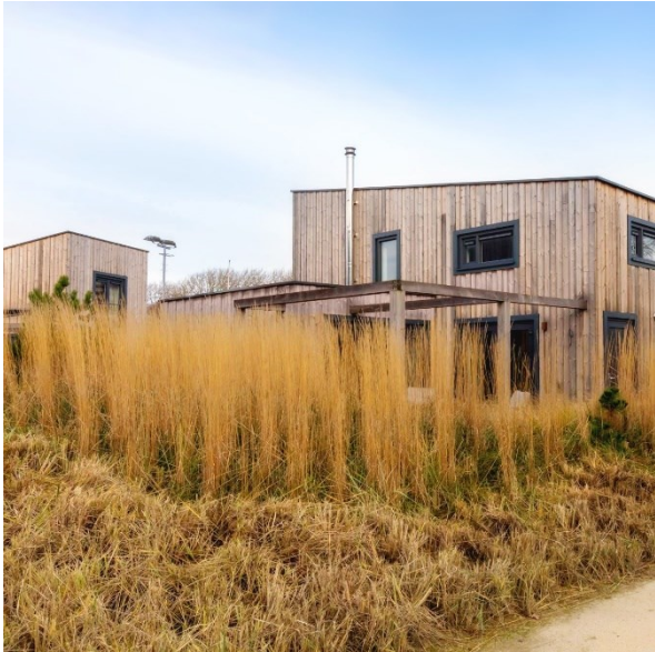
Afschermende beplanting en schapenhekken
