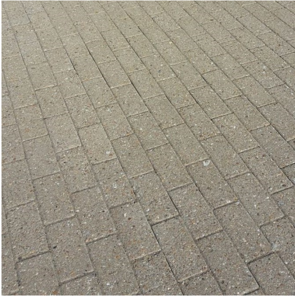
Kleine elementen verharding met schelpen toplaag en grasbetonstenen met grint
