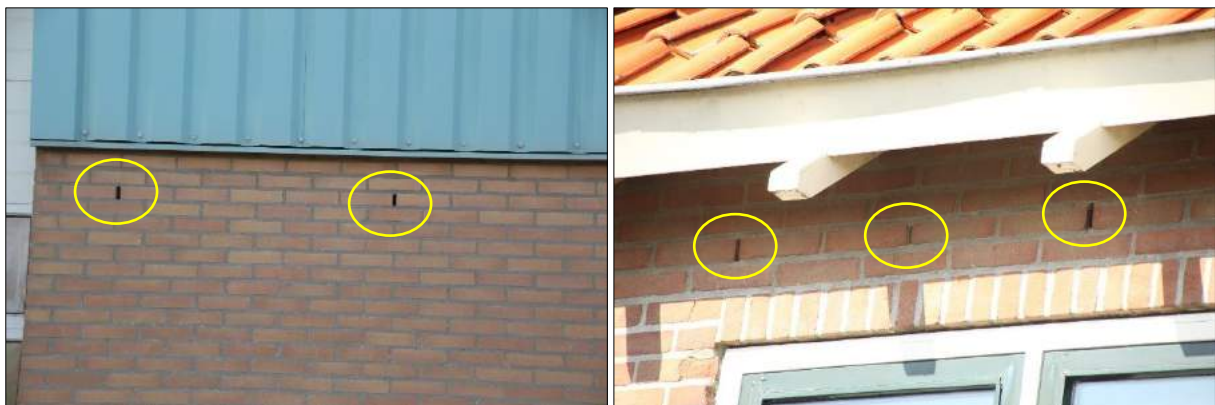
Open stootvoegen (gele cirkels) aangetroffen in de gevels van één van de loodsen en de woning op huisnummer 4.
