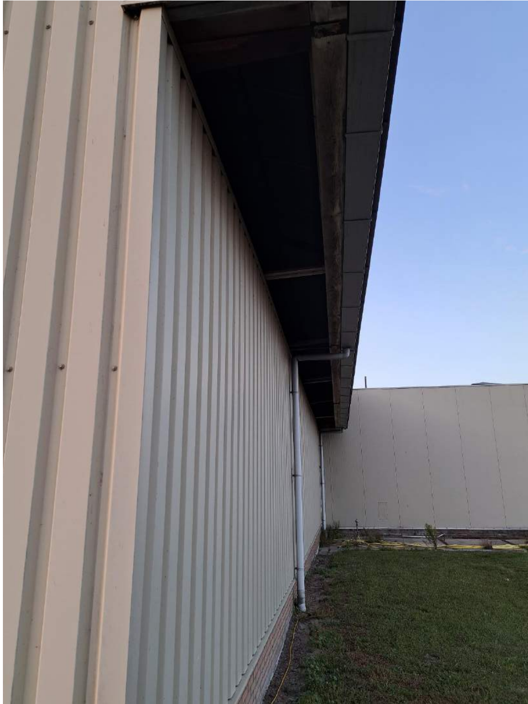
Dicht gemaakt met gas ter voorkoming van invliegende fauna in gebouw.
