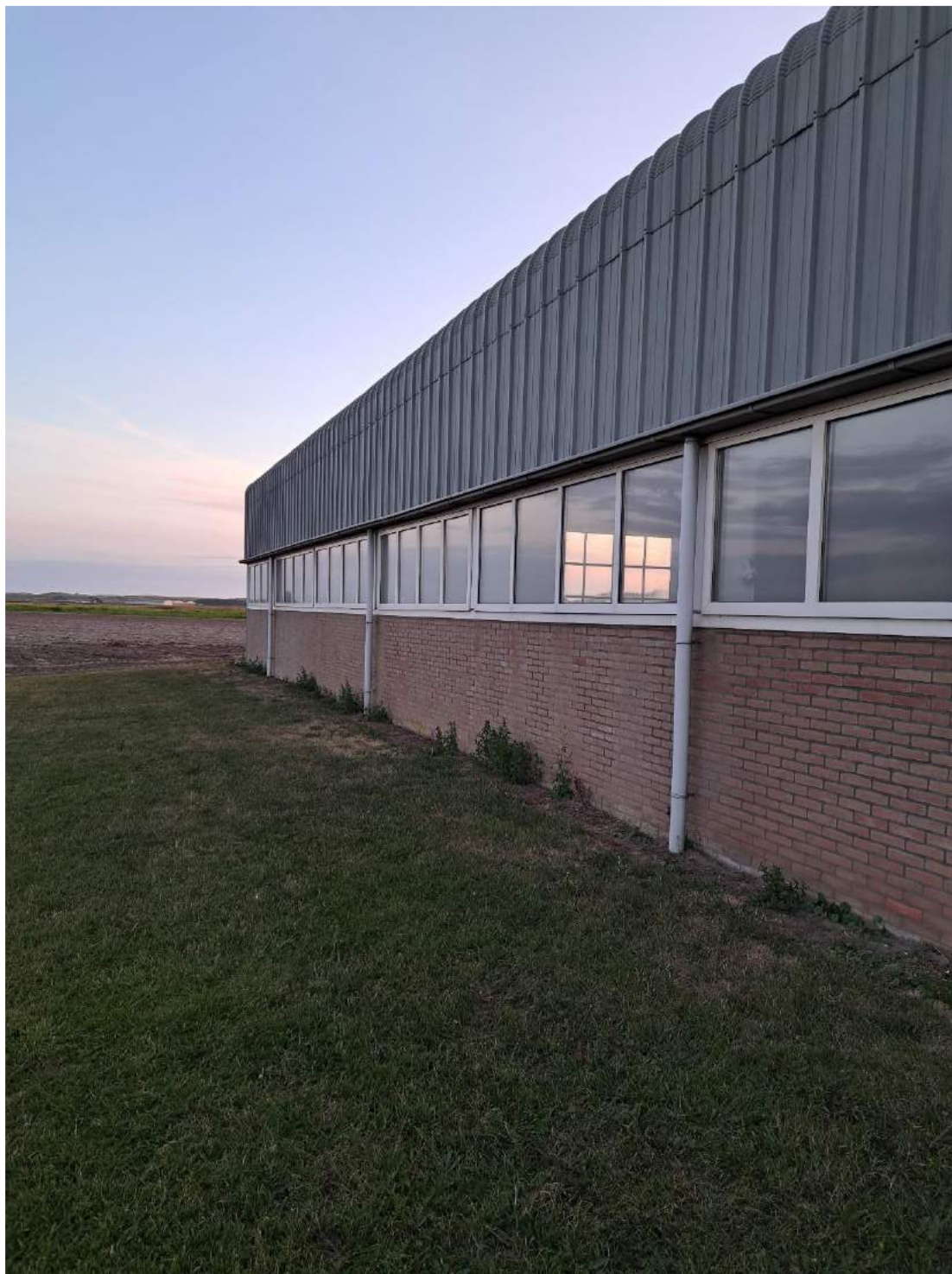
Enkelwandige schuren geen spouwmuur aanwezig
