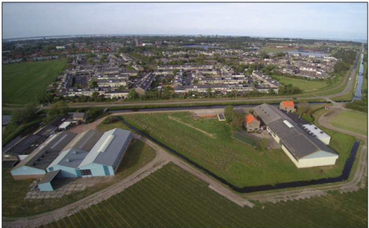
Afbeelding 2.3: Luchtfoto huidige situatie plangebied (Bron: B40)
