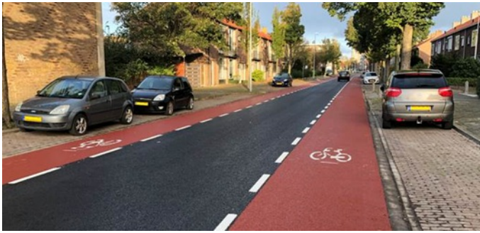
Vernieuwing asfalt met nieuwe fietsstroken Sportlaan
