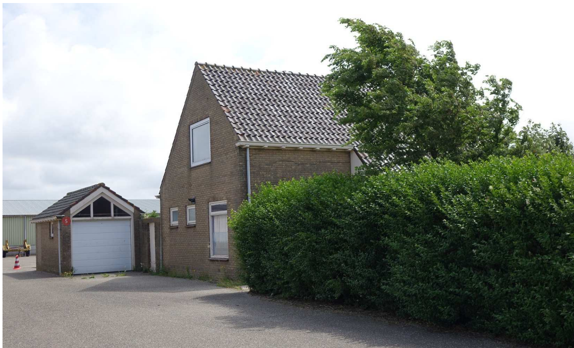
Figuur 2. De te slopen woning en garage aan de Nieuweweg 35 te Den Helder
