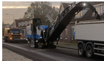
Tuinstraat/Sportlaan is gefreesd, nieuwe toplaag aangebracht met fietsstroken.
