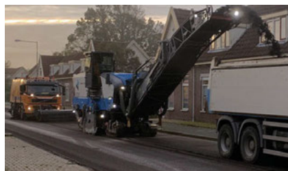
Tuinstraat/Sportlaan is gefreesd, nieuwe toplaag aangebracht met fietsstroken.
