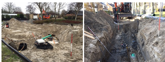
Aanleg riolering Vliestroomstraat
