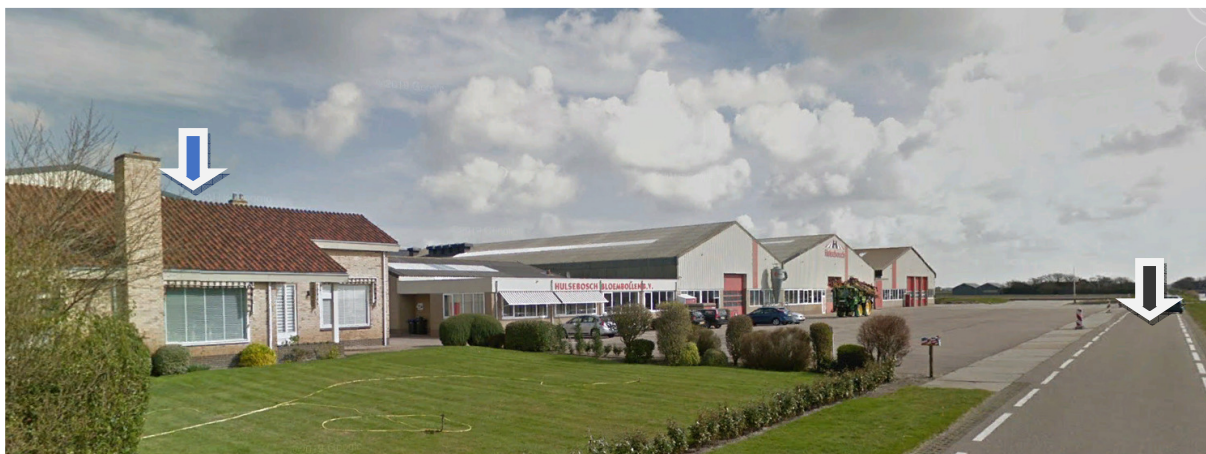
Afbeelding 4: Bestaande bebouwing, gezien vanaf de Middenvliet (zuidwest van planlocatie) (bron: Google Streetview)
