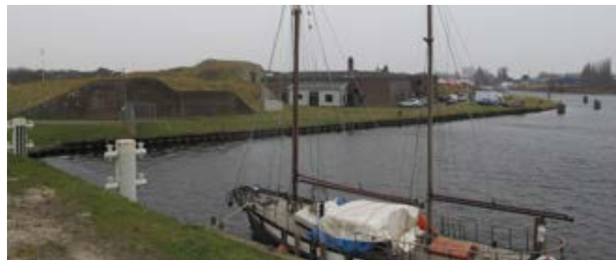
Westoever: delen zijn goed bewaard gebleven. In het fort is een bomvrij gebouw uit 1828-1830 voor 200 man.
