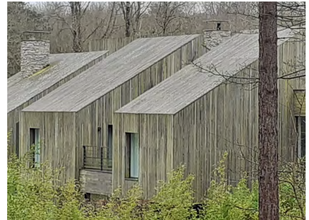
Ruim toegepast houten materiaal
