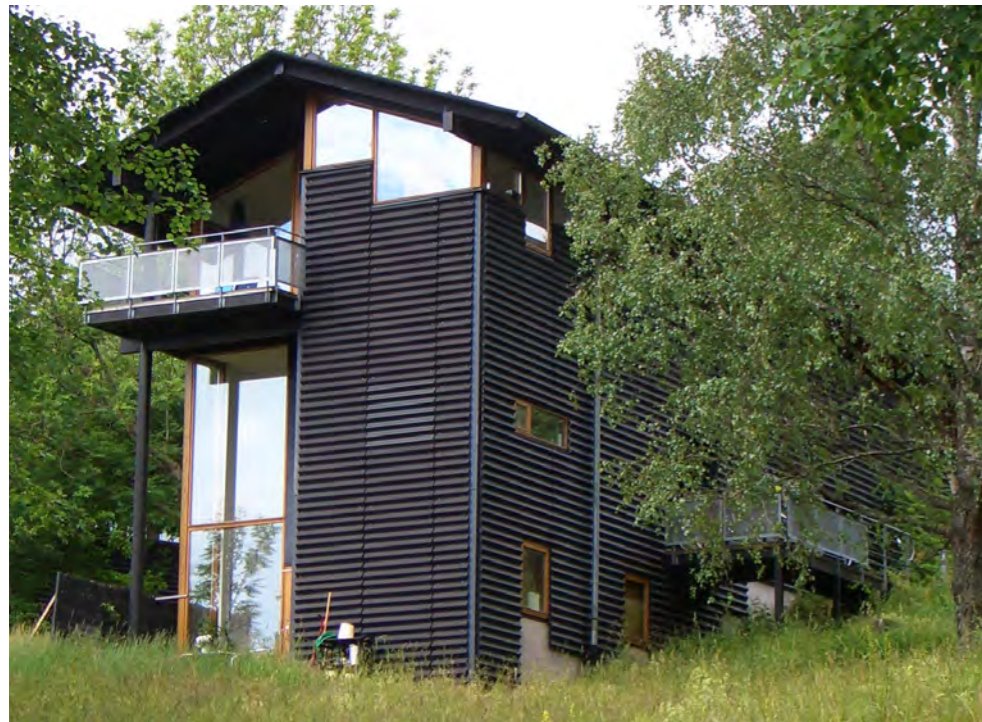
Open kopgevels met glas en raampartijen gericht op het groen
