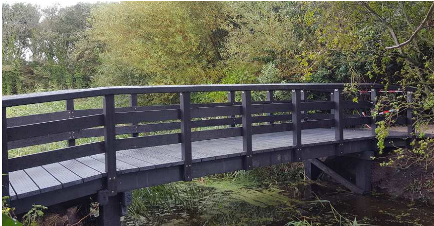
Figuur 1: Brug 81 Composietbrug Lichtbaaklaan
