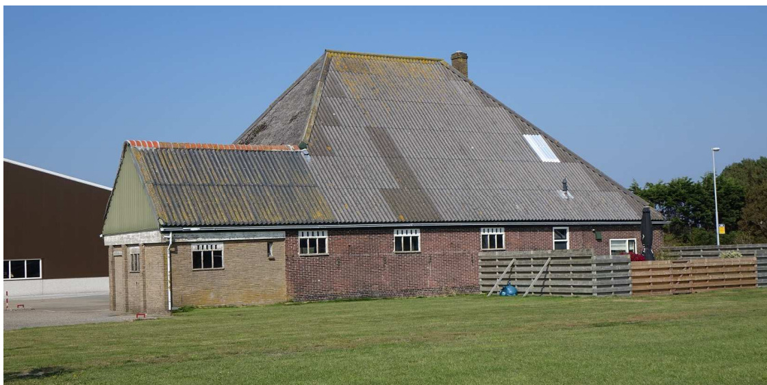
Figuur 2. De te slopen stolp aan de Langevliet 8 te Julianadorp
