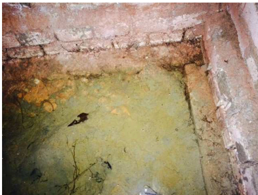
Klei op de bodem van de kruipruimte
