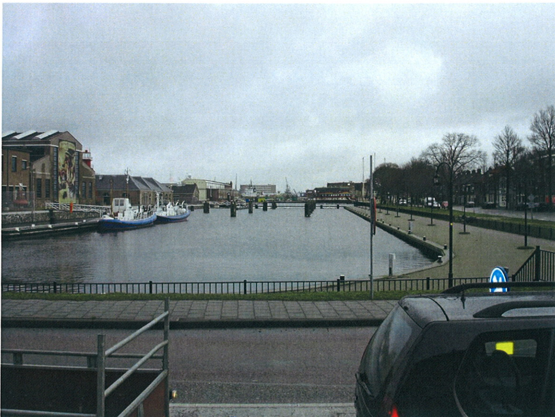
Willemsoord (gezien vanaf Weststraat)
