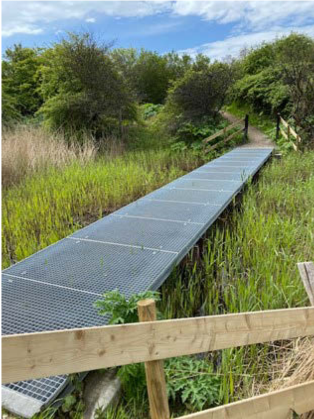
Nieuwe brug bij fort Dirksz Admiraal
