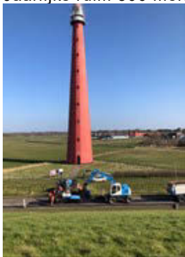
Nieuw asfalt op het Schapendijkje
