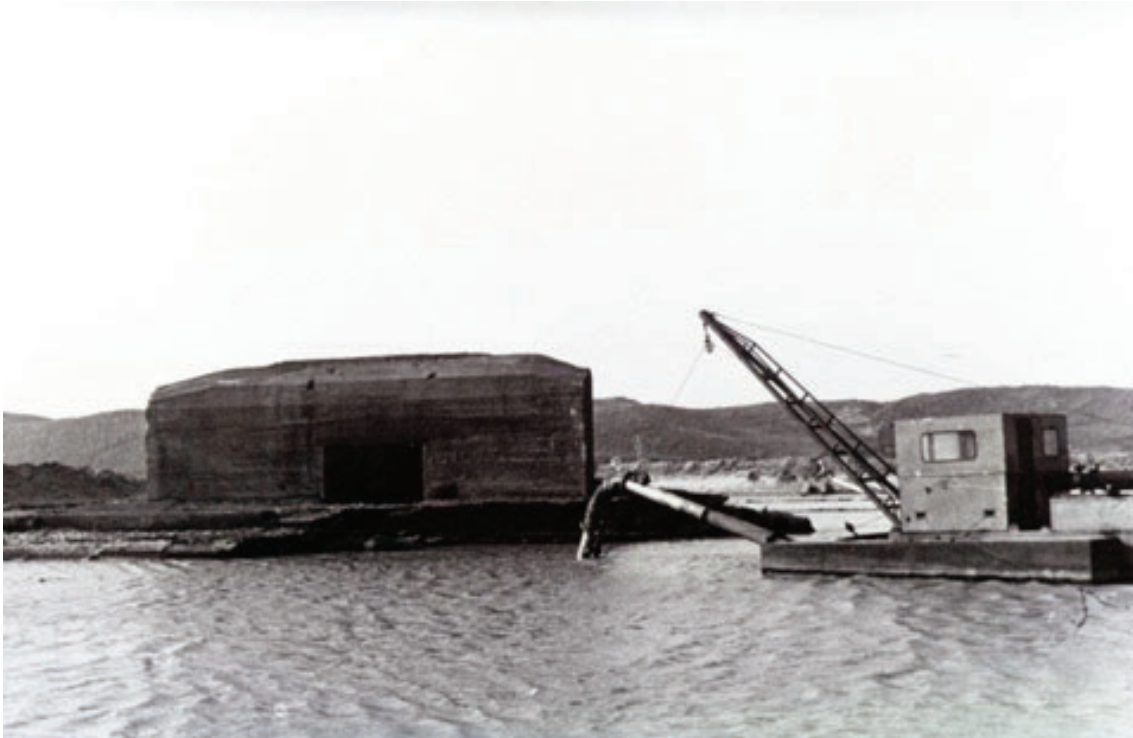
Afb. 5.21. Een bunker van het type 680 wordt afgezonken voor de kust van Julianadorp aan Zee, zonder jaartal (bron: Atlantikwall Platform)
