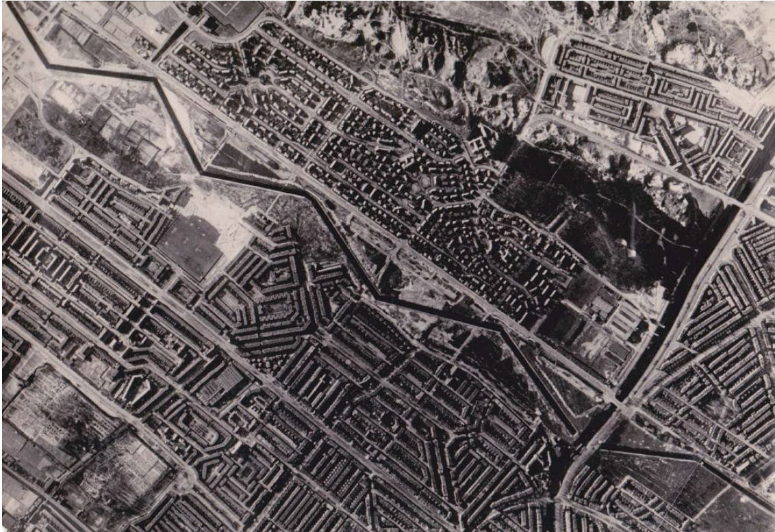
Afb. 4.4. Voor de aanleg van de tankgracht in Den Haag werd een grote hoeveelheid bebouwing gesloopt, en werden omliggende huizen ontruimd (bron: Historiek.net)
