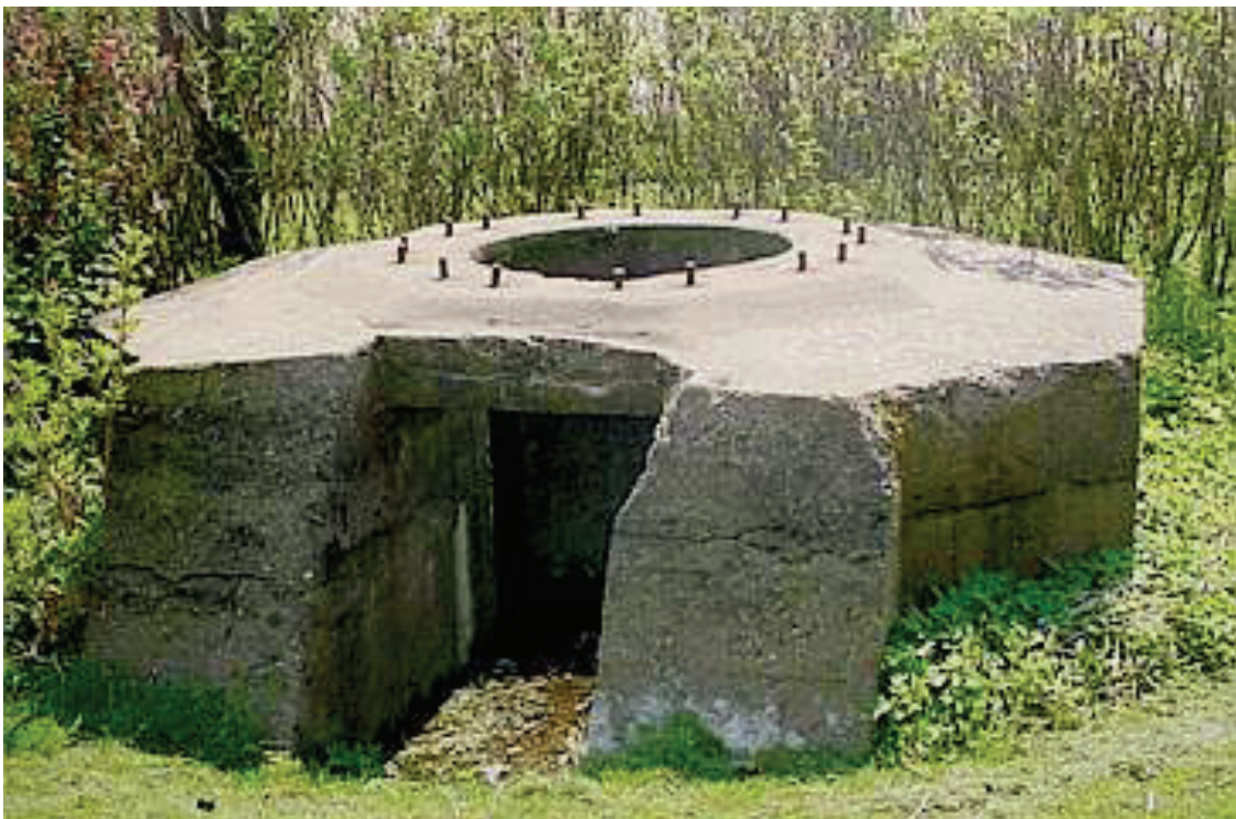
Afb. 5.26. Aan de Middenvliet waren meerdere mitrailleursnesten ingericht Bij één woning is de fundatie van een Mitrailleur nog intact (bron: https://www.julianadorp-parelvandekop.com/jdorp-wo2/jd3945at.htm )
