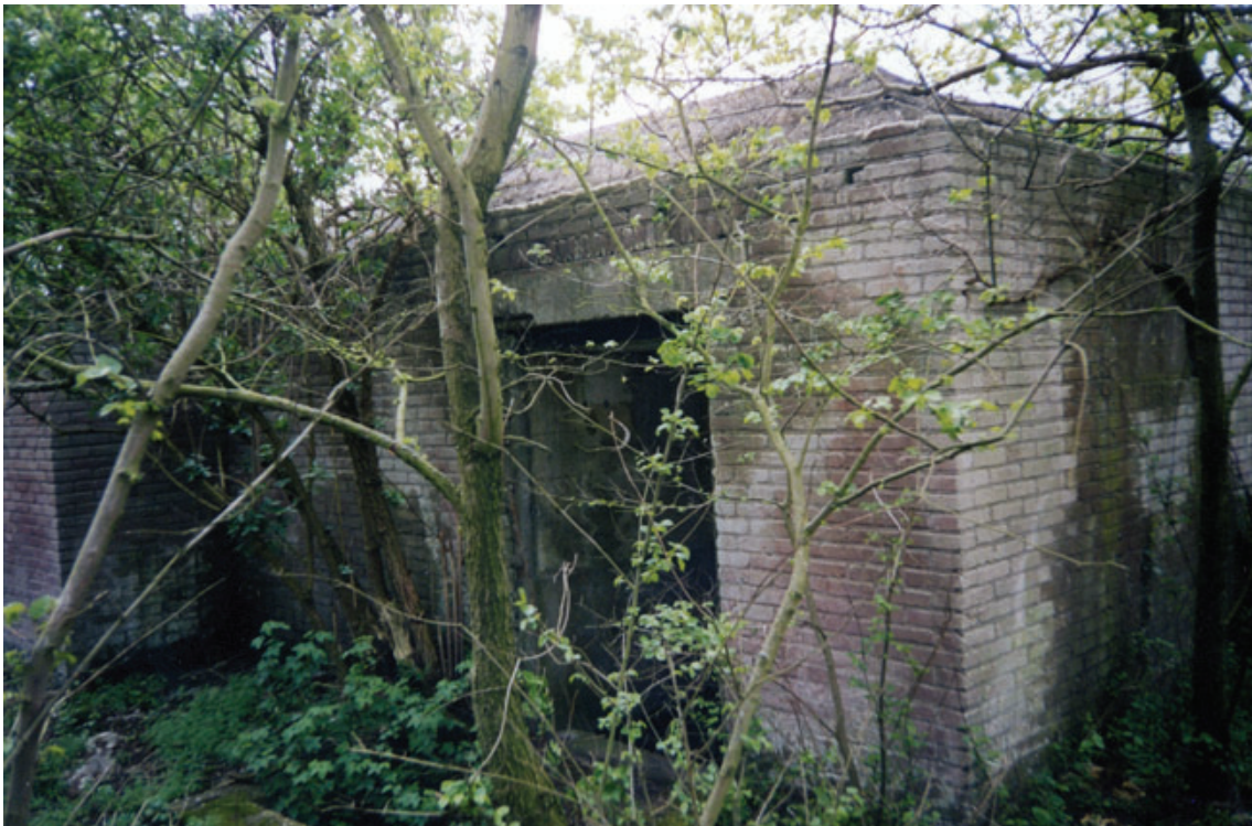
Afb. 5.24. VF1a aan de Middenvliet als onderdeel van de Neue Südlinie. De bunker was voorzien van een 'buitenmuur' ter camouflage. Zo moest de bunker lijken op een schuurtje of een woonhuis (bron: Stichting Stelling Den Helder)
