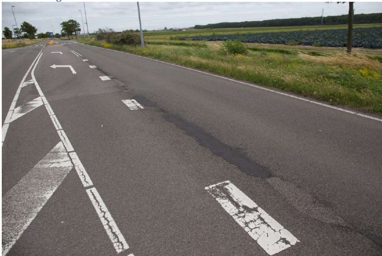
Openstaande naden en gerepareerde naden
