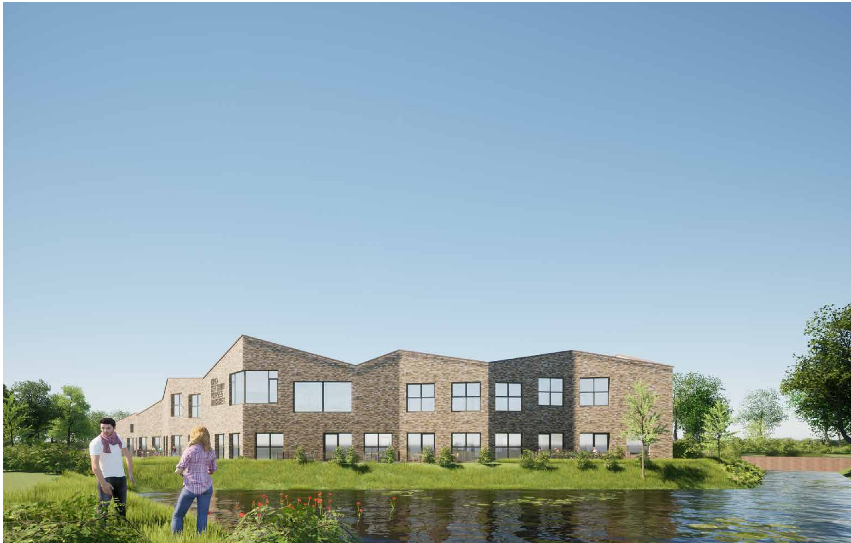
Gevel aan vanaf de waterpartij
